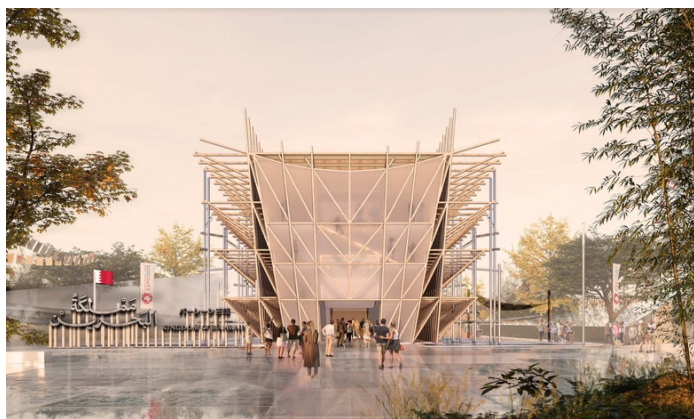
Fig. 5.13: Esterno del padiglione del Kuwait (Fonte: Lina Ghotmeh – Architecture).
