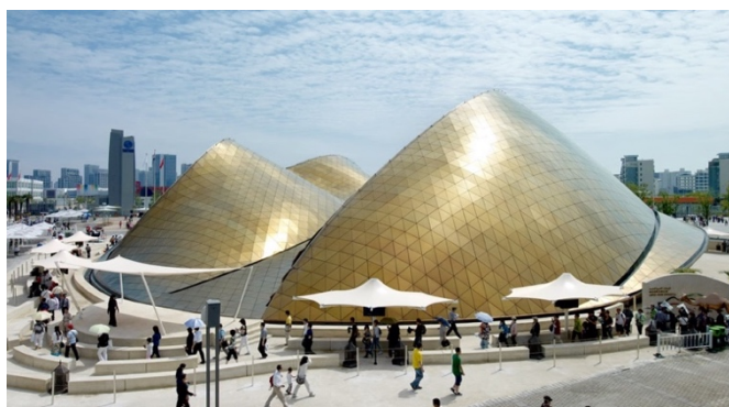
Fig. 5.2: Esterno del Padiglione (Fonte: Foster + Partners).
