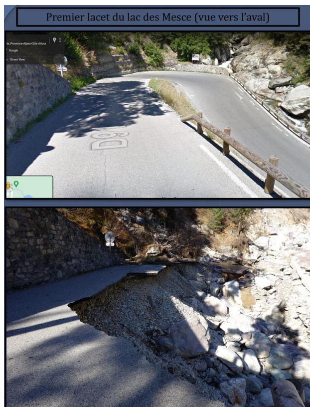
Figura n°18: fotografie della strada RD91 che porta a Casterino prima e dopo il passaggio della tempesta Alex
