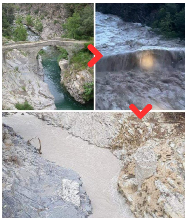
Figura n°15: ponte di Fanghetto (paese che si trova nel Val Roya, nella parte italiana - Liguria) prima della tempesta, la sera della tempesta e dopo 37
