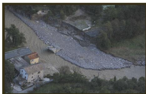
Ponte di "Ambo" Val Royà nel 2020
