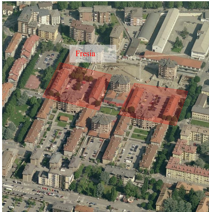
Figura 13. Edifici Gazzera e Fresia
