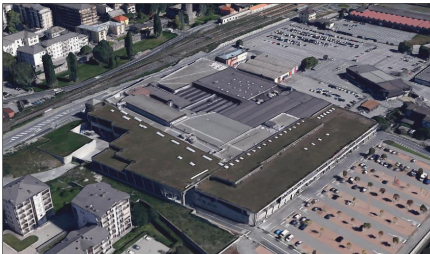
Figura 3.5 Gros Cidac, vista aerea sul tetto verde che ricopre parte del parcheggio Fonte: https://earth.google.com/web/@45.73164284,7.3170778,580.79098762a,288.46717322d,35y,34.10724007h,60.49977717t,0r (consultato il 31 luglio 2021)
