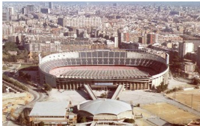
Figura 2.3. Veduta dall'alto dello Stadio del FC Barcelona e del Palau Blaugrana (1992, Vol. II, p. 211)
