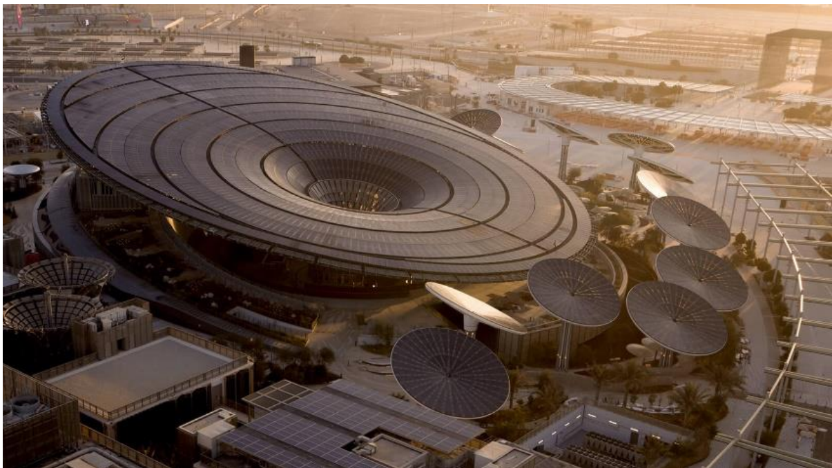
Figura 2.2: Il padiglione "Terra" a EXPO DUBAI 2020
