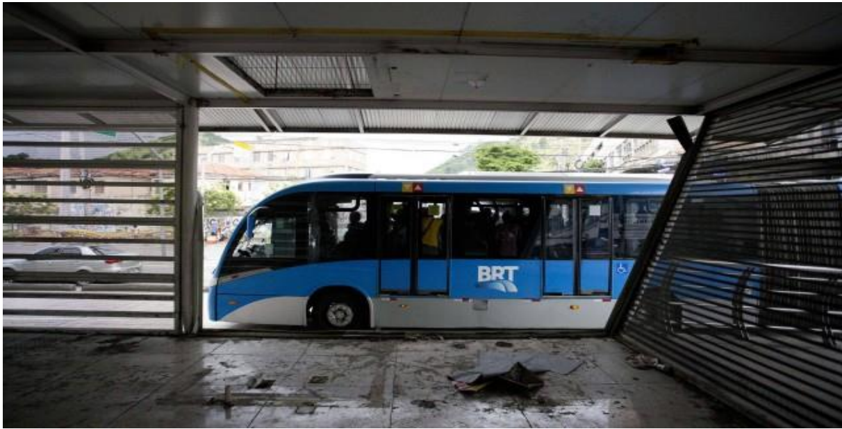
Figura 3.3 Stazione abbandonata della BRT sul corridoio Transoeste
